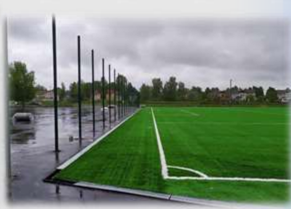
Капитальный ремонт стадиона в деревне Добрунь
