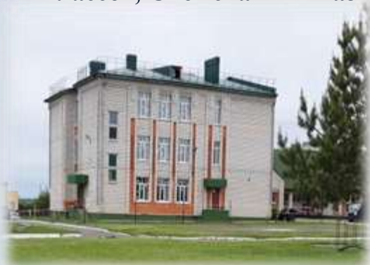
Капитальный ремонт кровли и замена оконных блоков в Гимназии №1 Брянского района
