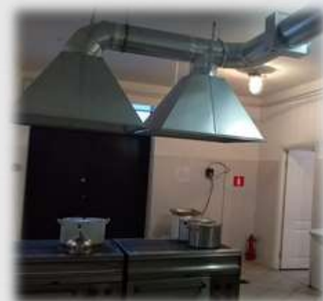
Ремонт пищеблока в Малополпинской СОШ
