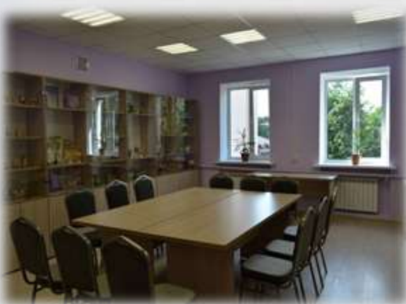
Ремонт Глинищевского культурно-досугового центра
